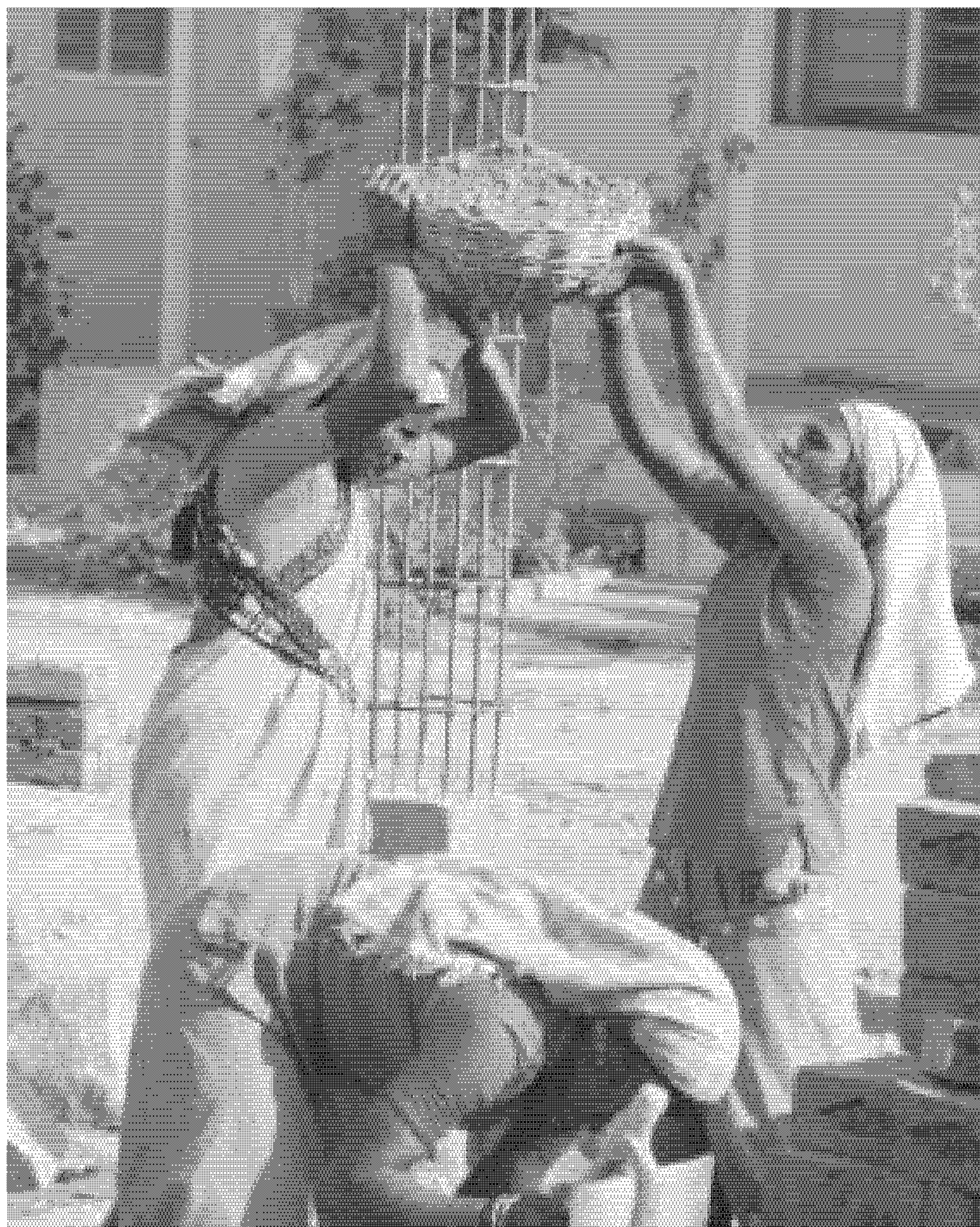
Varias mujeres construyen viviendas en Anantapur.
