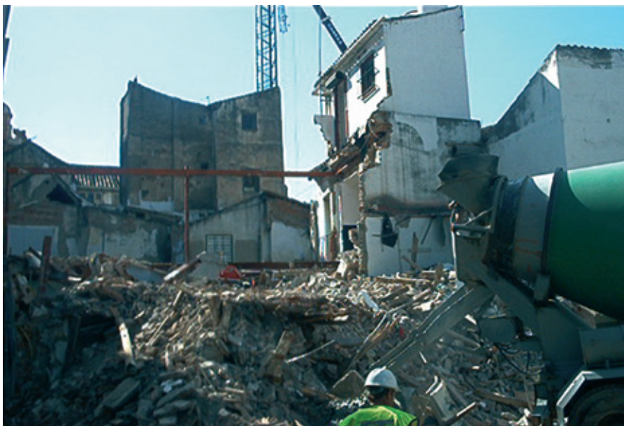
Máquinas demoledoras y excavadoras durante las obras de demolición en la judería de Málaga, para reacondicionar la zona. 2002. Foto de la autora.
