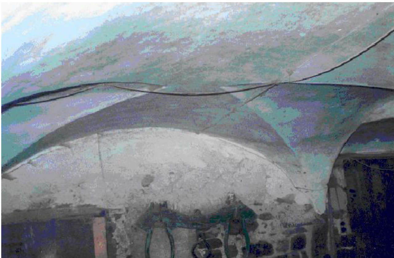
Forjado de bóveda en planta baja
