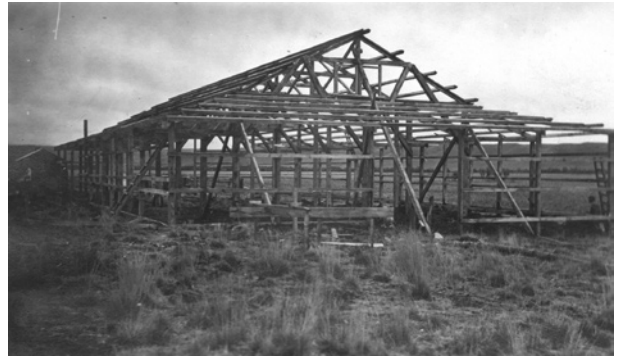
El aserrado de maderas y la industrialización del clavo permitieron el desarrollo de las estructuras de entramado que alcanzaron amplia difusión en la Patagonia tanto argentina como chilena. La imagen ilustra la construcción de un galpón de esquila en los primeros años del siglo XX, en el sur argentino. (Fte: CEDODAL)
