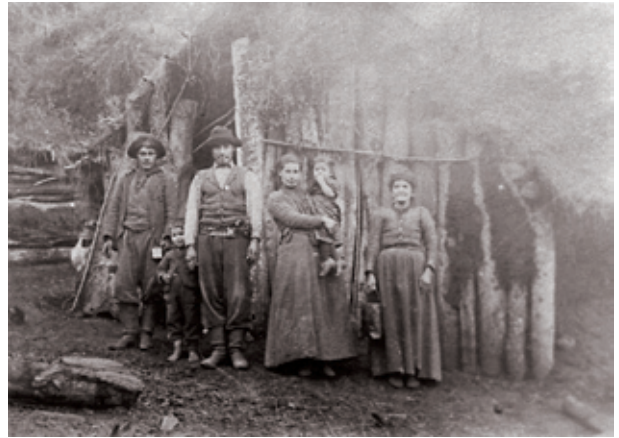
Los galeses que se radicaron en los valles cordilleranos aprovecharon, en cambio, la abundancia de bosques maderables. Entre las primeras arquitecturas figuran las construcciones con troncos verticales –“palo a pique”– o con troncos horizontales –blocao– labrados a mano. (Fte: Museo de Trevelin, Chubut, Argentina)
