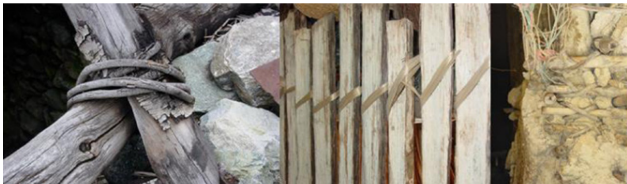
Vista del amarre de los componentes de la horconadura, estructura principal del sistema. (Fotos Carla Pereira, Nelly Mejía, y Nory Pereira)
