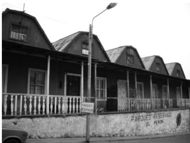
Fachada norte, porche y mojinetes, del conjunto Gambetta
