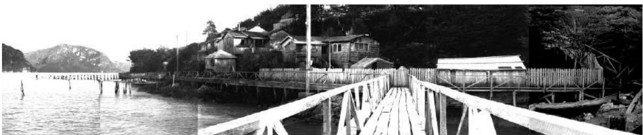
Pasarela de Ciprés en Rincón Bajo (Galle, 2000)
