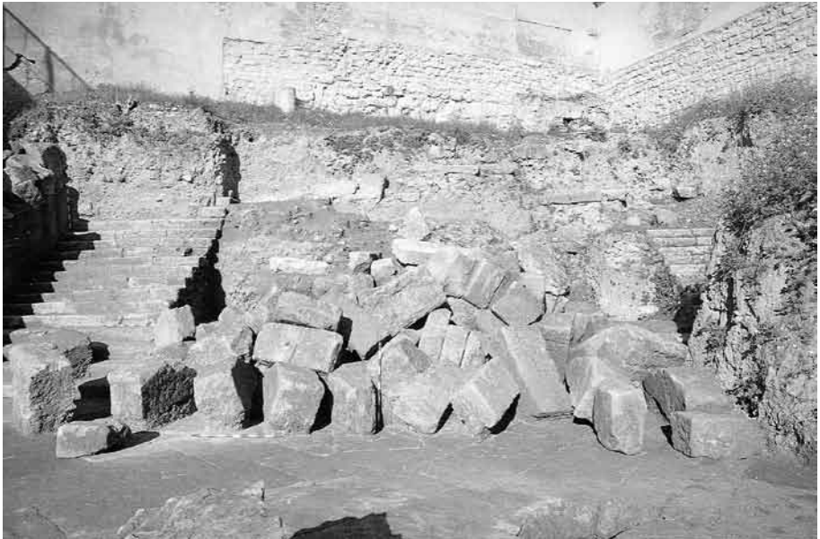
Fig.3. Derrumbe del muro de contención entre plaza superior y media. Foto A. Ventura Villanueva.
