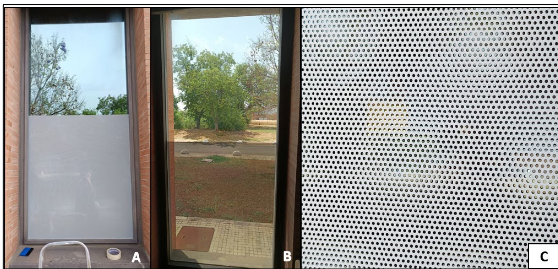
Figura 7. Prueba 2: vinilo microperforado blanco. A: Instalación exterior. B: Vista interior. C: Detalle del vinilo. Fuente: Elaboración propia .
