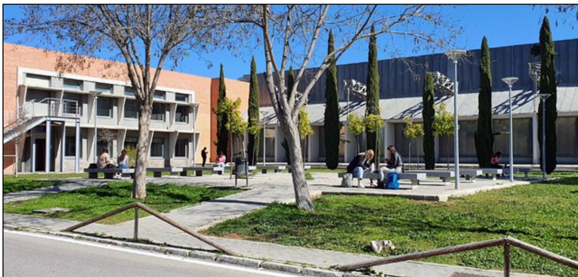
Figura 3. Fachada lateral del edificio 25 “Juan Bautista Muñoz” (Biblioteca / C.R.A.I.), próxima al canal. Fuente: Biblioteca. Universidad Pablo de Olavide.
