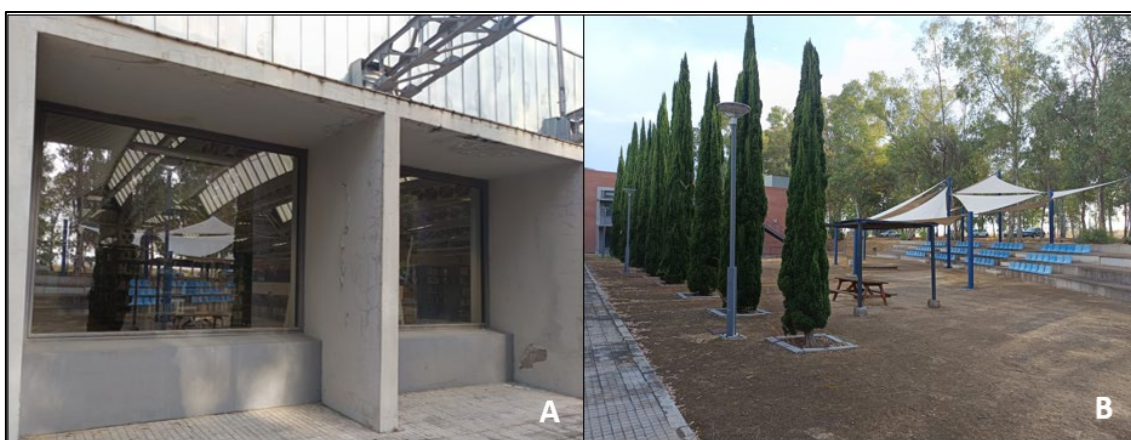
Figura 5. Fachada lateral del edificio orientada al parking con eucaliptos. A: Ventanales amplios. B: Gradas exteriores y zona de uso universitario. Fuente: Elaboración propia.
