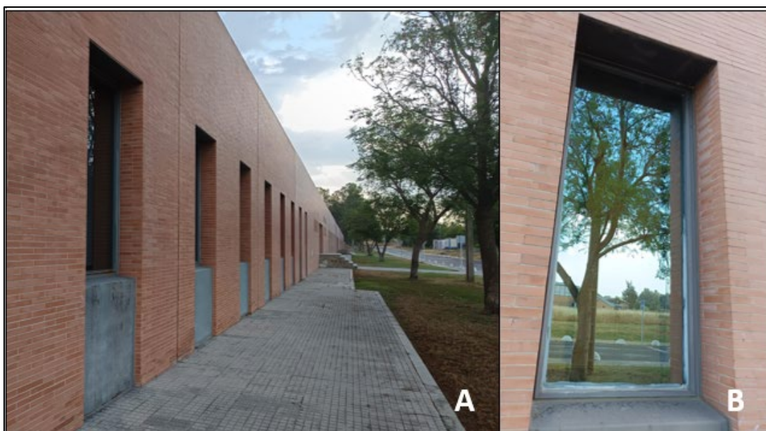
Figura 4. Parte de la fachada trasera del edificio. A: Vista general. B: Detalle de una ventana con reflejo de vegetación. Fuente: Elaboración propia.
