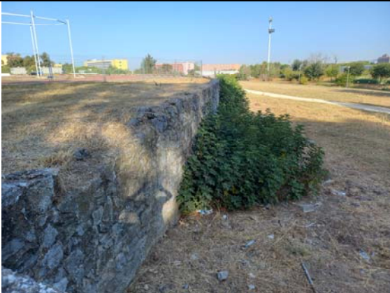
MURO CONTENCIÓN PIEDRA
