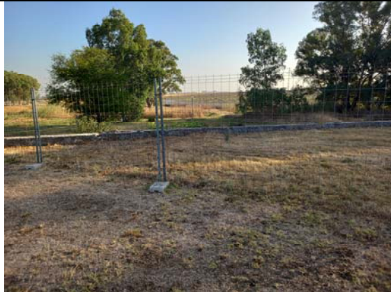
MURETA Y VALLADO PROVISIONAL
