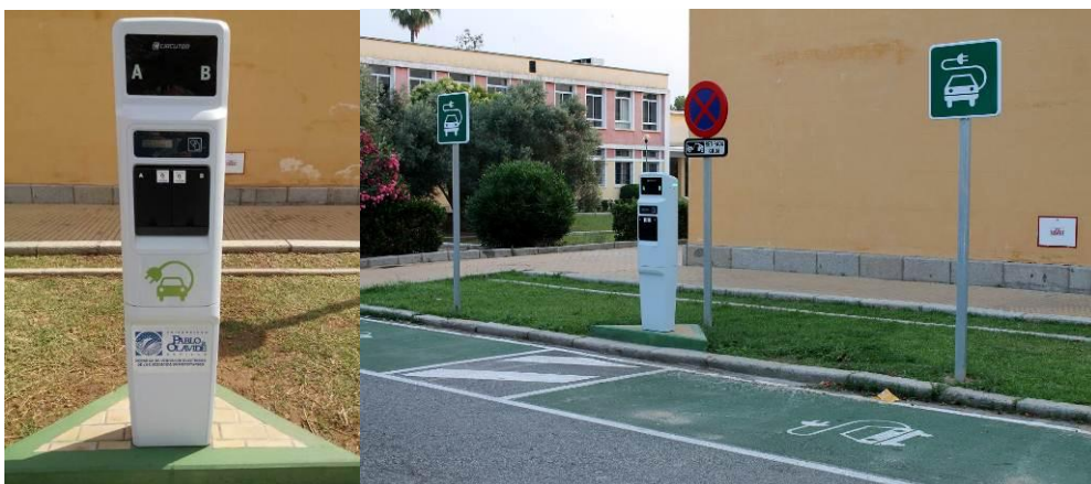
Ubicado entre los edificios 7 y 9. Aparcamiento P2.
