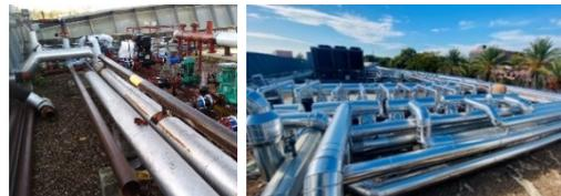
3. Reforma de la instalación de climatización de las aulas 1, 2, 4 y 5 en el Edificio n.º 8 (Conductos exteriores y castilletes en planta de cubierta; Conductos interiores, rejillas de impulsión/retorno y sondas de control de temperatura/HR/CO2 en aulas), con aprovechamiento de los equipos actuales.
