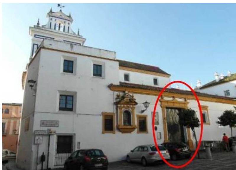
Exemple de modification structurelle due à l'ouverture d'une nouvelle porte dans la nef de l'Épître de l'église de Santiago (Séville, Espagne) dans la seconde moitié du XXe siècle.
