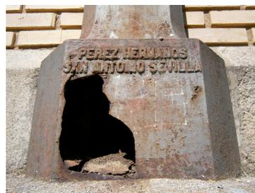
Fotografía. 1. Vista de la pilastra de obtención de la muestra metálica.
