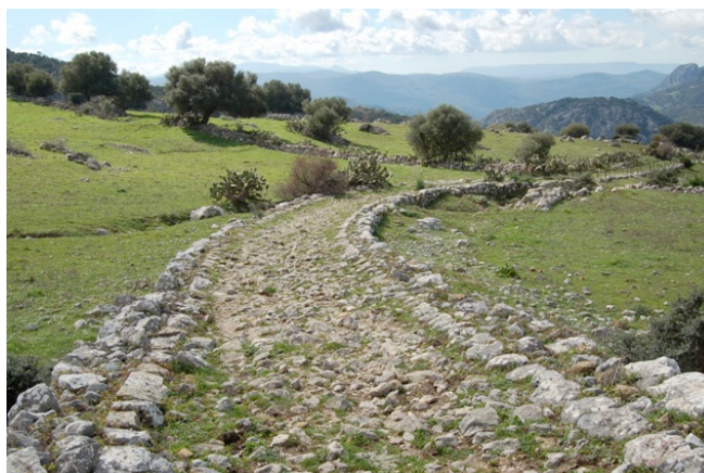
Fig.4. Estado actual de calzada romana en la provincia de Cádiz [11]
