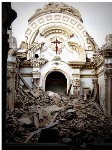
Fig. 1. Colapso de la Iglesia de Santiago de Lorca, Murcia, tras el seísmo de 2011.
