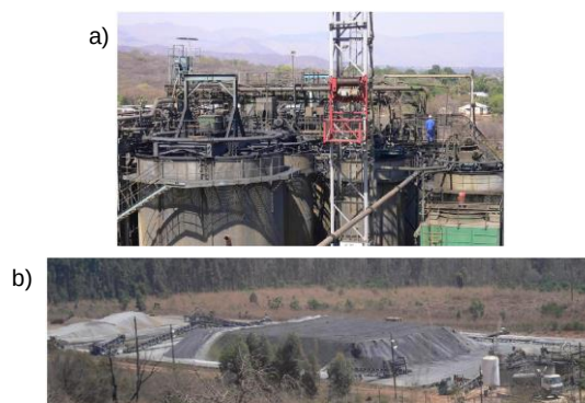
Fig. 2. Plantas industriales de biooxidación de sulfuros metálicos. a) Tecnología BIOX™ en Fairview (Sudáfrica). b) Biorreactor tipo pila en Agnes (Sudáfrica) [8].
