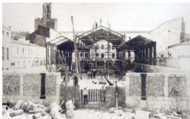
Fot. 1. Construcción del Edificio Metálico
