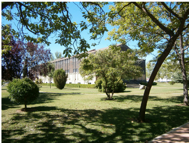
Fot. 7. Vista de la fachada lateral
