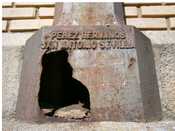
Fot. 10. Vista de la pilastra de la obtención de la muestra metálica
