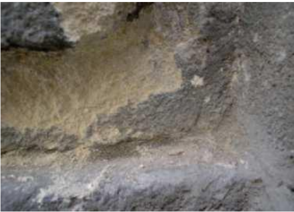
Fig. 5. Costras negras en el basamento de la pilastra izquierda en la portada lateral de la iglesia de San José. (Ortiz et al., 2012)
