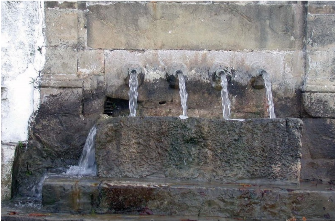
Fuente del Matadero en Benahocaz, de mineralización muy débil (conductividad eléctrica de 322 \mu S/cm en diciembre de 2002), utilizada para abastecimiento urbano de la localidad (1)
