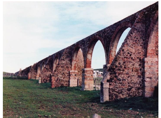
Acueducto del Cobre
