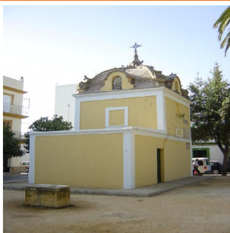
Caja de aguas en Puerto Real
