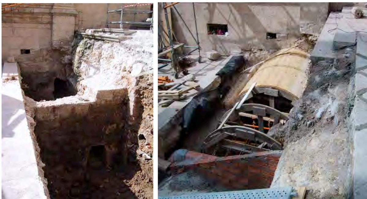
Imagen con parte de la escalera de acceso al Sarmental desmontada y la excavación realizada donde pueden apreciarse las trazas del paso histórico existente al que se hacía referencia en el Plan Director.
