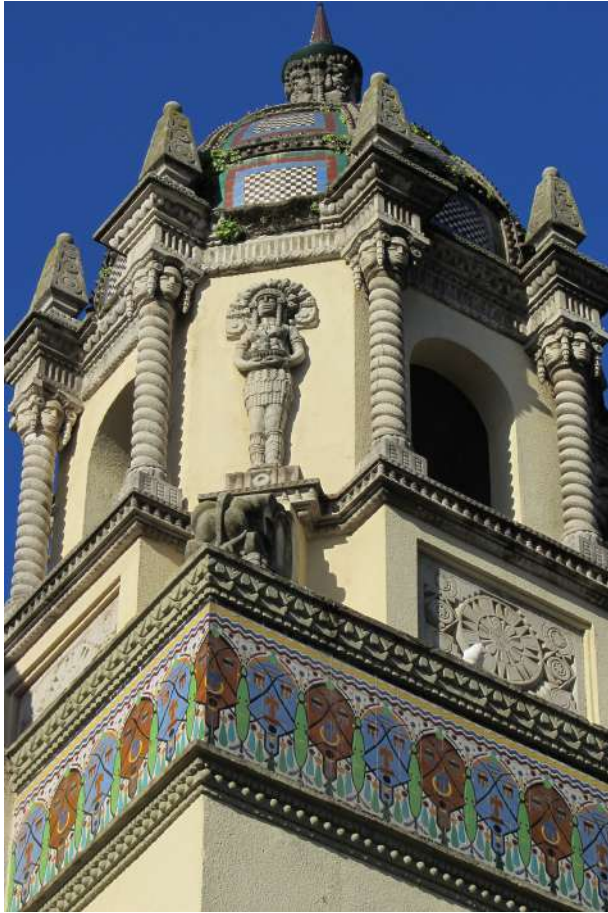
2. Pabellón de Colombia. Detalle del edificio. Exposición Iberoamericana de Sevilla. 1929. Foto: Zara Ruiz Romero, 2013.
