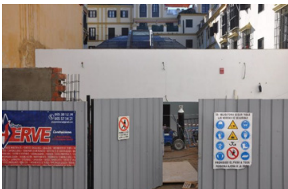
Obras de rehabilitación y creación de fachada
