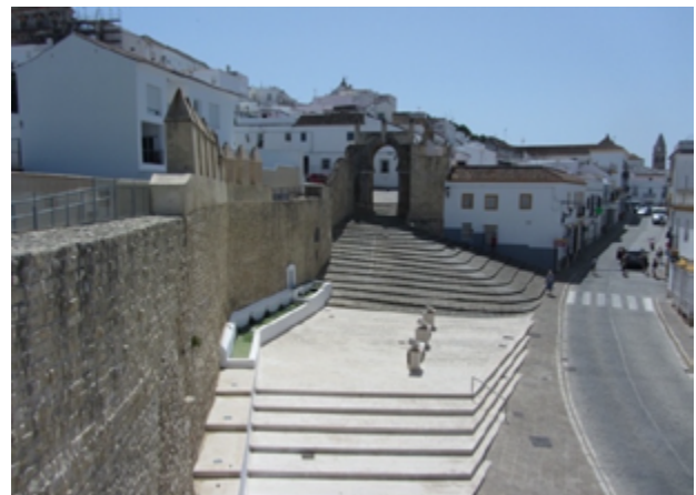
Muralla y vista desde la torre noroeste 2020, Zara Ruiz Romero
