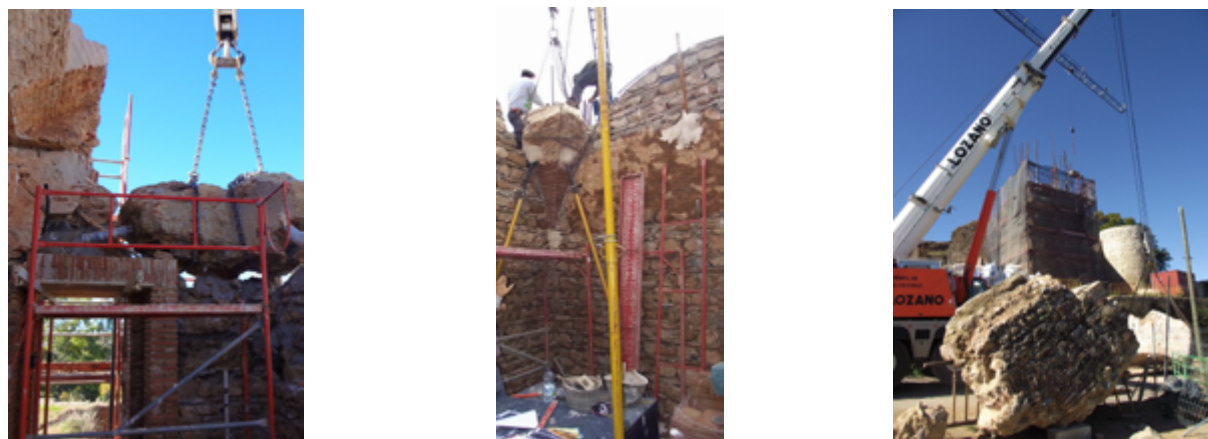
Recolocación de piezas originales en la torre del homenaje 2013-2014, Fernando Vilaplana Villajos
