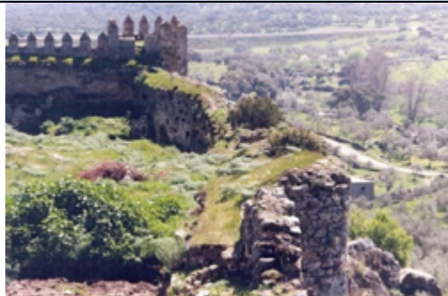
Interior, esquina suroeste
