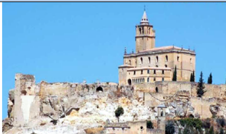
Muralla zona del Gaván 2009, Carlos y Clemente Porras Funes
