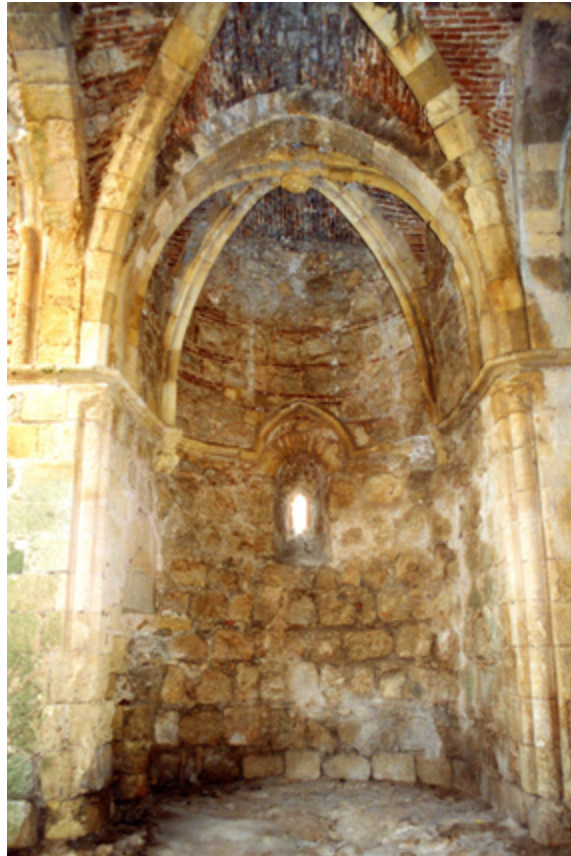
Figura 5. Interior de la torre de Cote (fot. I. Capilla, 1998).
