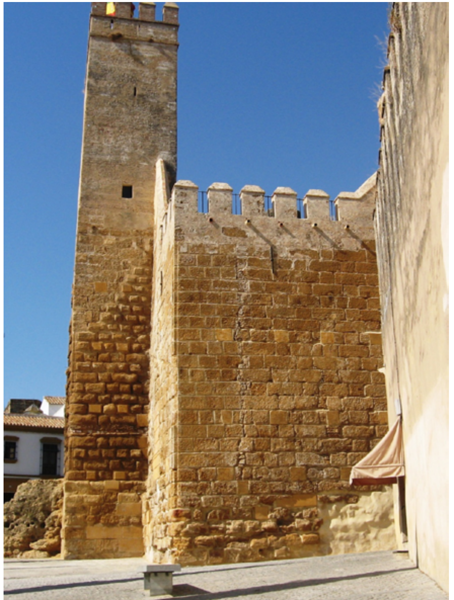
Figura 9. Aspecto final de la intervención en el Bastión del Alcázar de la Puerta de Sevilla con la Torre del Homenaje al fondo (fot. Eduardo Martínez Moya, 2011).
