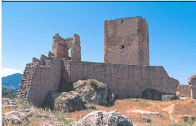
Fachada y acceso principal 2003
