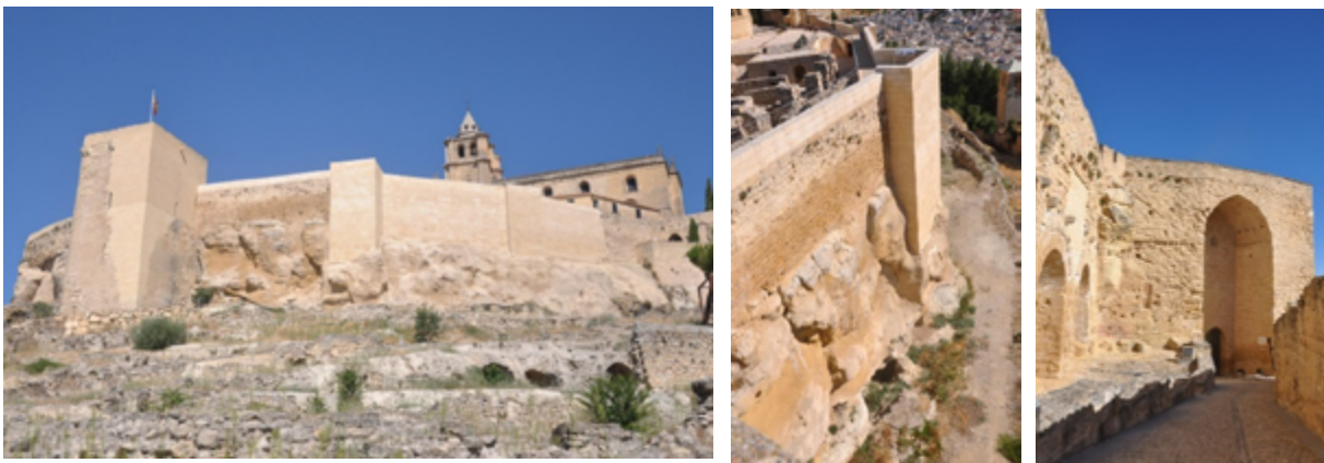
Exterior de la muralla zona del Gaván, detalle de su apoyo y zona E y puerta de la Imagen 2020, M.ª Gracia Gómez de Terreros G.
