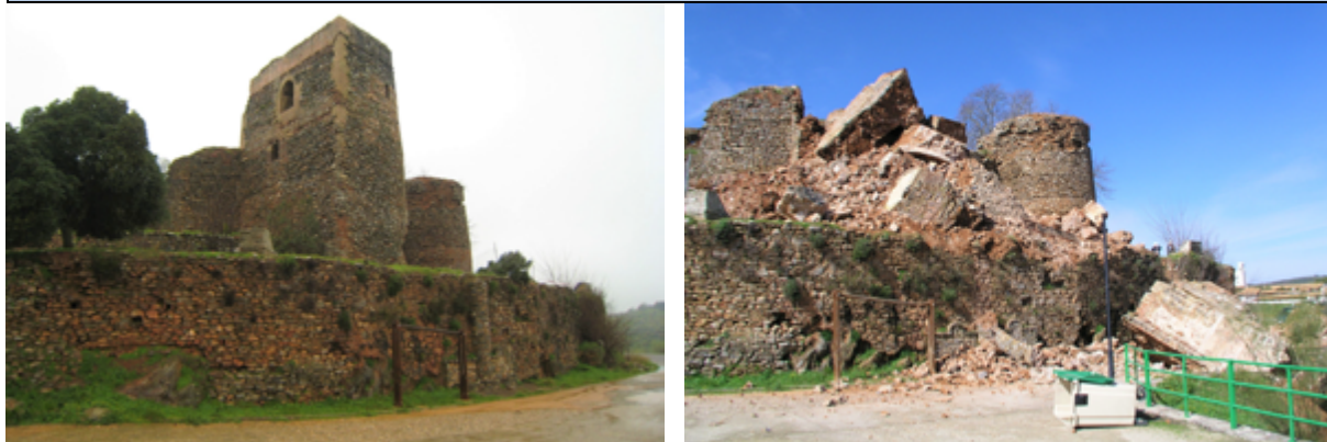
Torre del homenaje 2009 (izquierda) y 2010 (derecha), Fernando Vilaplana Villajos
