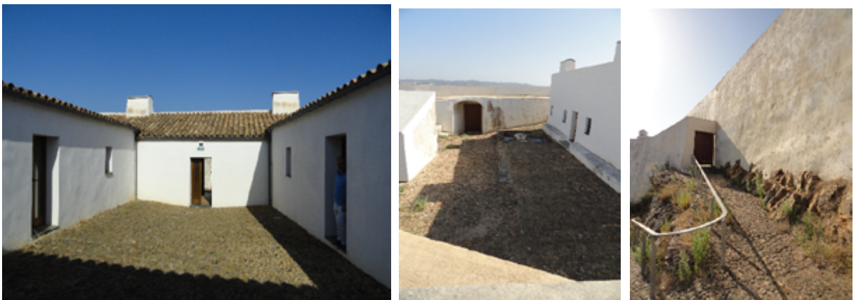
Patio del cuartel de la tropa, entrada norte desde el interior y exterior 2020, Pedro Gómez de Terreros Guardiola
