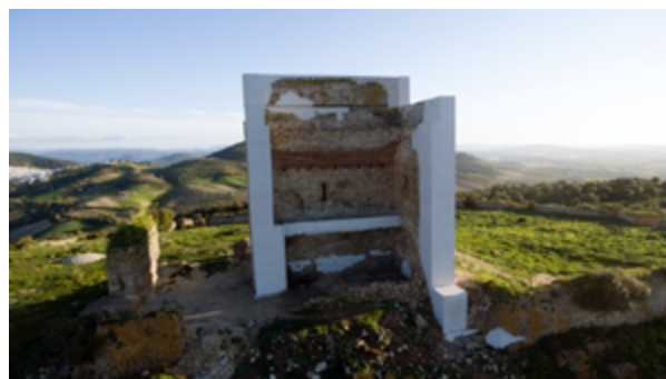
Torre del homenaje (exterior e interior) y recinto amurallado Carlos Quevedo Rojas
