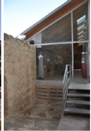
Espacio zona caballerizas
