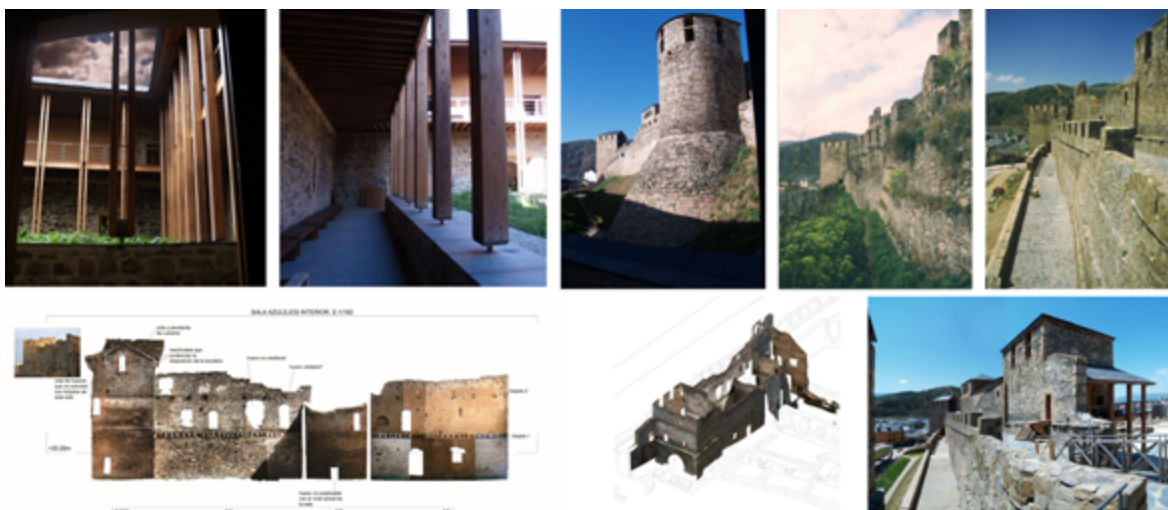
Figura 27. Firmitas. Castillo de Ponferrada. Recuperación de la estructura de madera.
