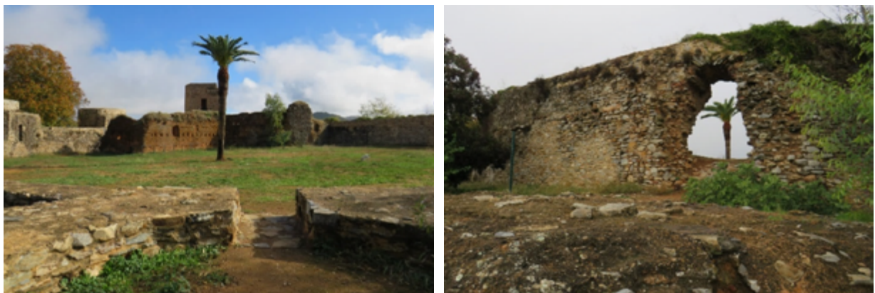
Patio de armas (al fondo la torre del homenaje) y lienzo de muralla 2020, Victoria Sánchez Mellado
