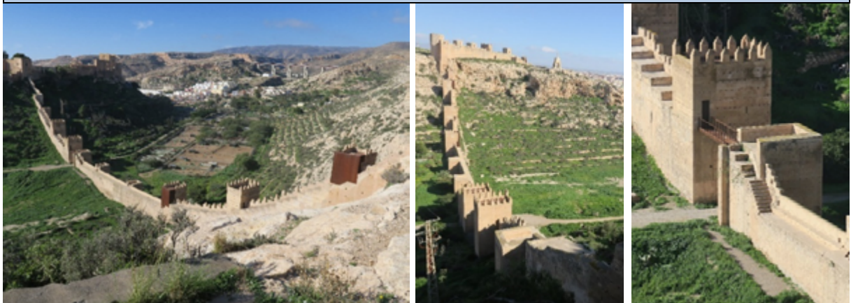
Muralla vista desde el cerro de San Cristóbal y la Alcazaba; y acceso entre torres 4 y 5 2019, M.V. Gómez de Terreros G.
