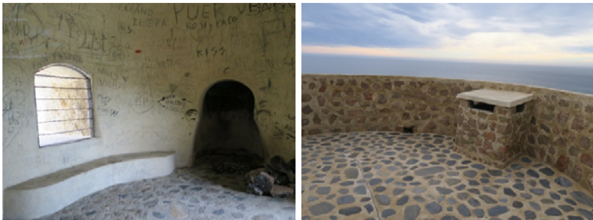
Cámara interior con vano y chimenea; y terraza superior con salida de humos y pretil 2019, M.ª V. Gómez de Terreros G.
