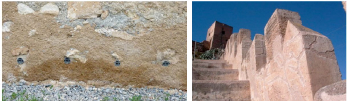
Higrconectores en funcionamiento y consolidación de paramentos y revestidos ca. 2012, cedidas por Jesús M. Basterra Pinilla
