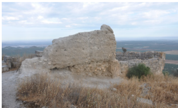
Edificio de tapial al norte. Vista exterior
