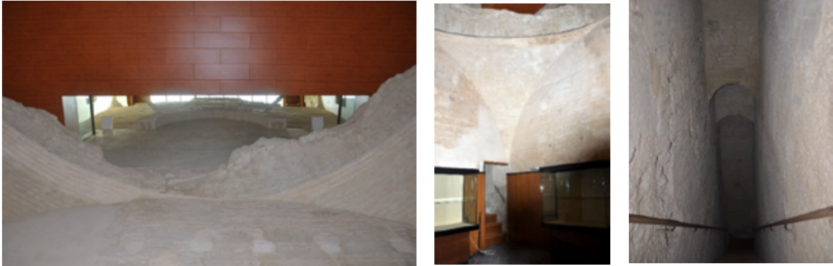
Hueco para iluminación en planta baja y escalera a planta primera 2020, María Gracia Gómez de Terreros Guardiola
