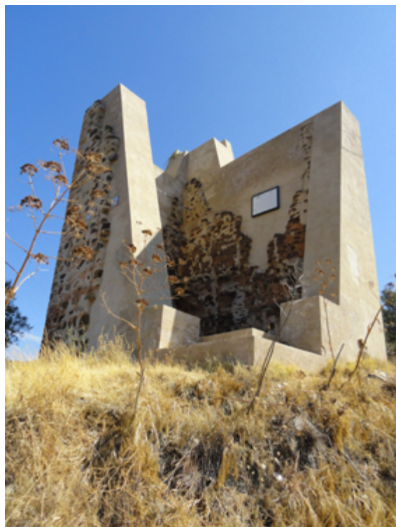
Figura 11. Torre Salazar de Totalán, Málaga (fot. Pedro Gómez de Terreros Guardiola, 2020).
