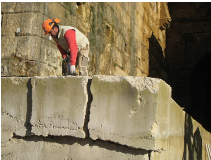
Figura 8. Finalmente la eliminación del lastre de hormigón armado anti-levantamiento (fot. Eduardo Martínez Moya, 2010).
