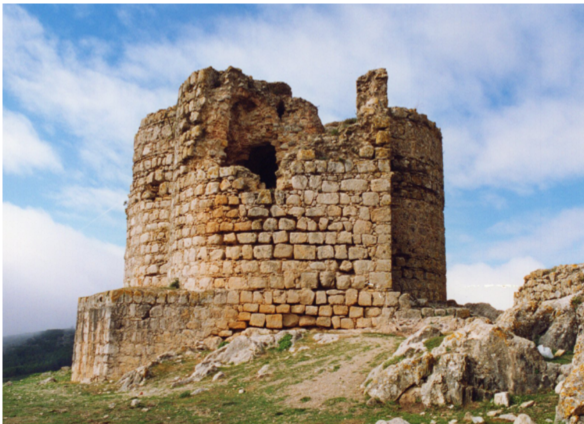
Figura 7. Vista del ábside oriental de la torre de Cote (fot. I. Capilla, 1998).
