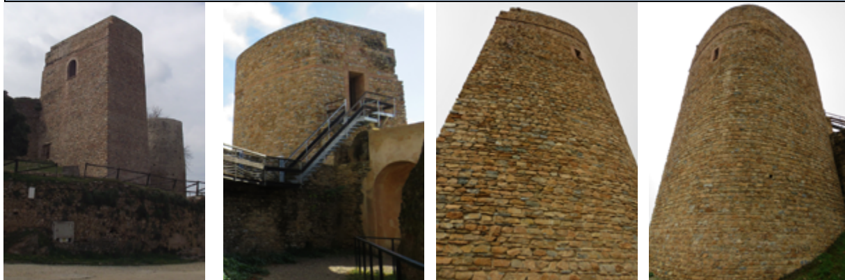
Frentes de la torre del homenaje 2015, Fernando Vilaplana Villajos (izquierda) y 2020, Victoria Sánchez Mellado (resto)
