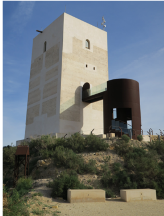
Figura 2. Torre de Huércal-Overa, Almería (fot. M. a del Valle Gómez de Terreros Guardiola, 2019).
