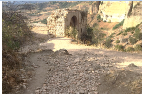
Camino de acceso a la puerta del Cristo 2017, S. Valadez Mateos
