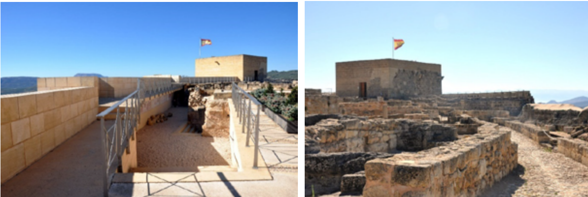
Trasdós muralla zona del Gaván, con adarve en voladizo y plaza alta y muralla zona sur 2020, M.ª Gracia Gómez de Terreros G.
