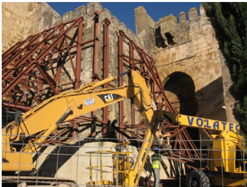
Figura 7. Primero la eliminación de las “velas”, lastradas por una parte y con una red de micropilotes inclinados en la otra (fot. Eduardo Martínez Moya, 2010).
