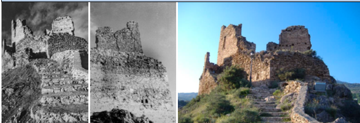
Estado previo del castillo y torre principal 1983, José Antonio Ramos
