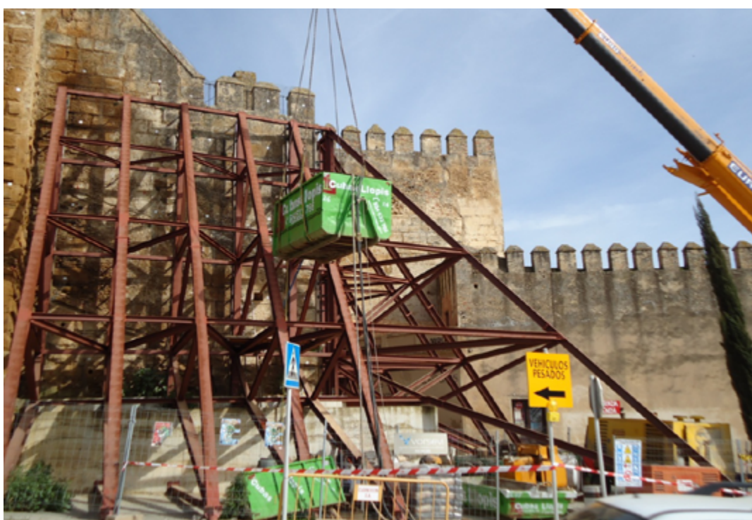
Figura 3. Método de perforación puntual de los muros de la esquina del Bastión de la Puerta de Sevilla de Carmona (fot. Eduardo Martínez Moya, 2010).
