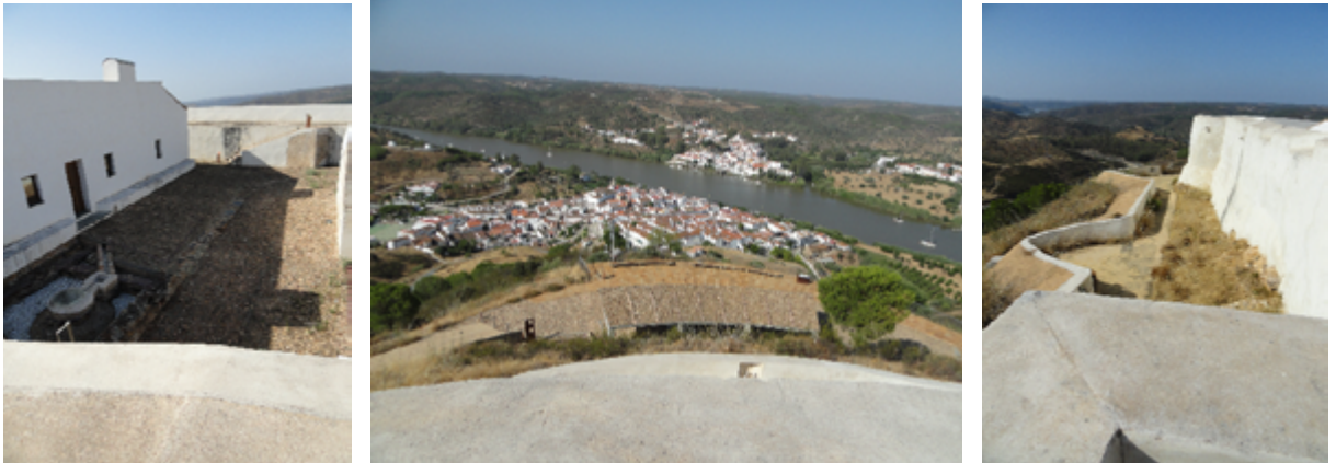
Cuartel de la tropa, cubierta del aparcamiento y foso exterior 2020, Pedro Gómez de Terreros Guardiola
