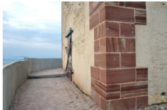
Zona baja esquina noreste y puerta de acceso cerrada
