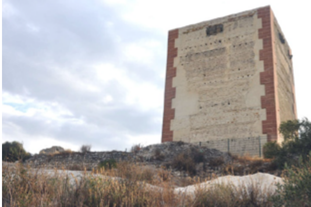
Vista general de la torre desde el oeste
