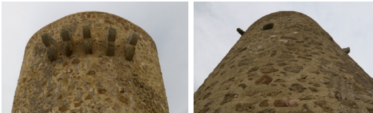
Detalle de las ménsulas a nivel de la cornisa y lado de la torre que da al acantilado con vano 2019, M.V. Gómez de Terreros
