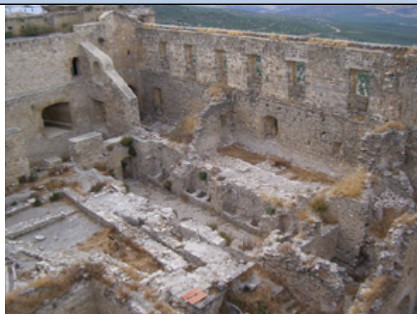
Patio principal, caballeriza y muro N 2007, Juan Carlos Guijano Moreno
