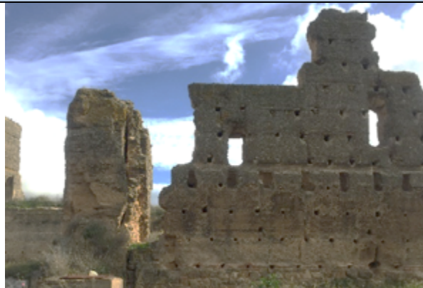
Muro oeste del palacio y torre del homenaje
