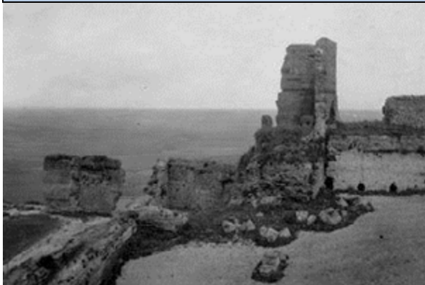
Zona norte y torre del homenaje
