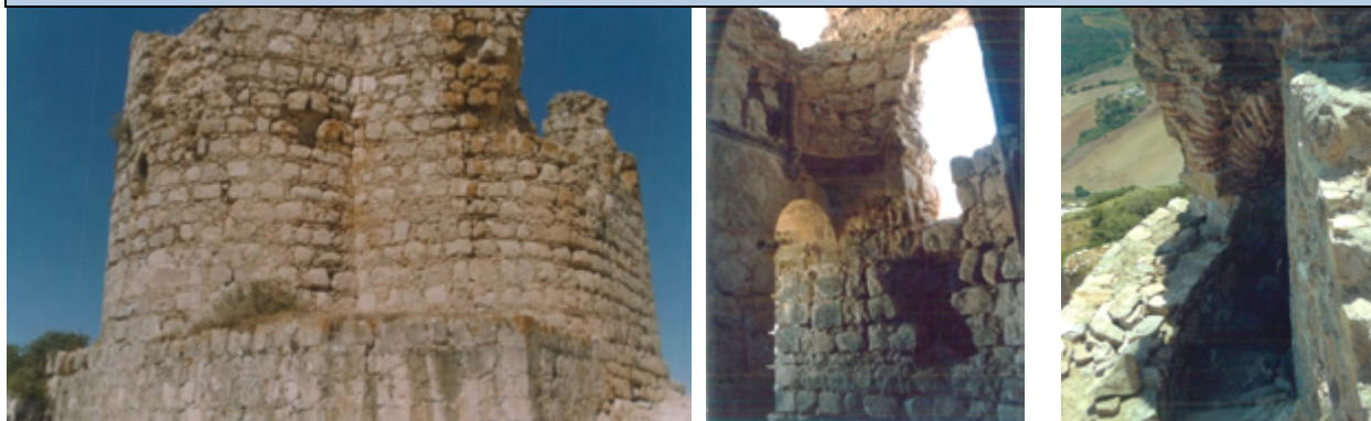
Vista exterior, ábside oriental desde el interior y escalera de acceso a la cubierta 1994 y 2002 (derecha), Antonio Rivas González
