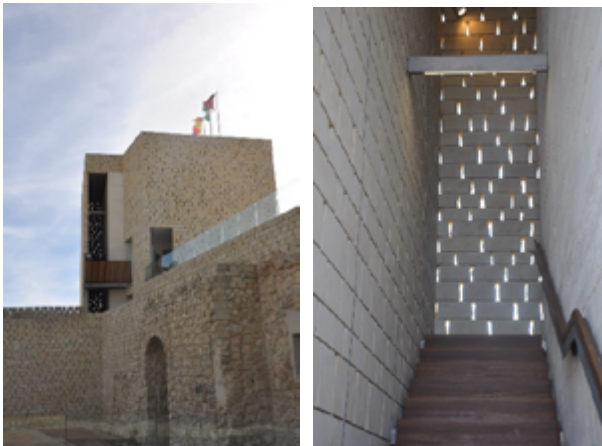
Vista desde el patio e interior de torre de las Arqueras
