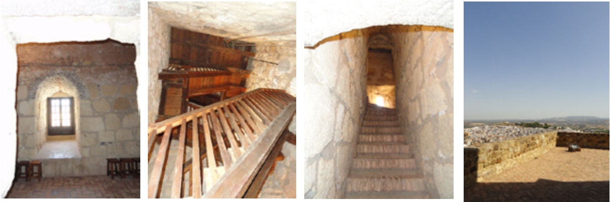
Sala interior en planta baja, primer y segundo tramo de escalera y terraza 2020, Pedro Gómez de Terreros Guardiola
