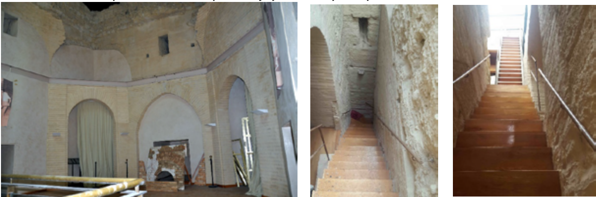
Planta alta y escaleras a cubierta 2020, María Gracia Gómez de Terreros Guardiola
