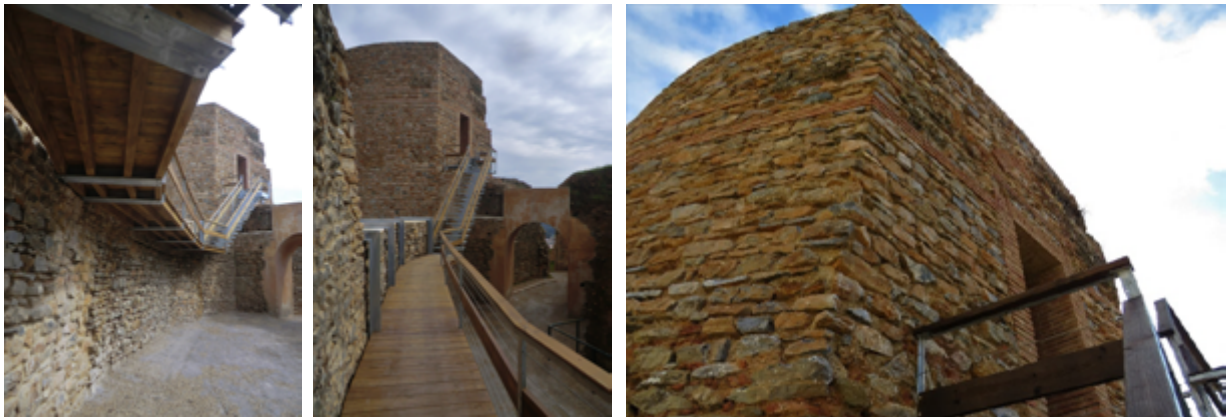
Camino de acceso a la torre del homenaje y detalle de la puerta de acceso a su cámara superior 2016, Fernando Vilaplana Villajos (izquierda y centro) y 2020, Victoria Sánchez Mellado (derecha)
