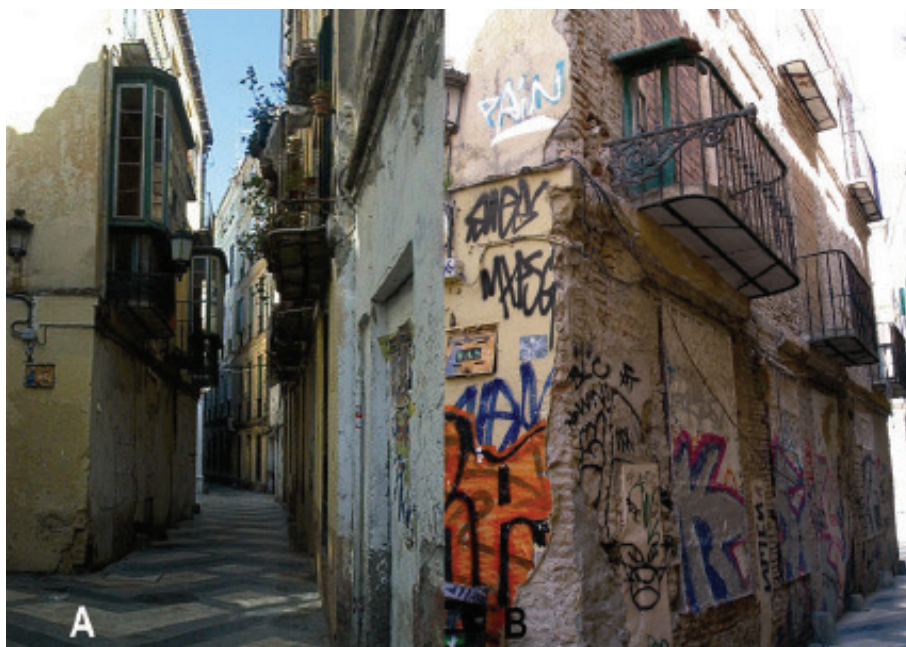
Fig. 3. Pérdida de la memoria urbana: Málaga, calle Beatas nº 43. A) Inmueble en 2002, cuando aún permanecía habitado y B) Idem. en 2006, totalmente en ruinas. Fotos de la autora.
