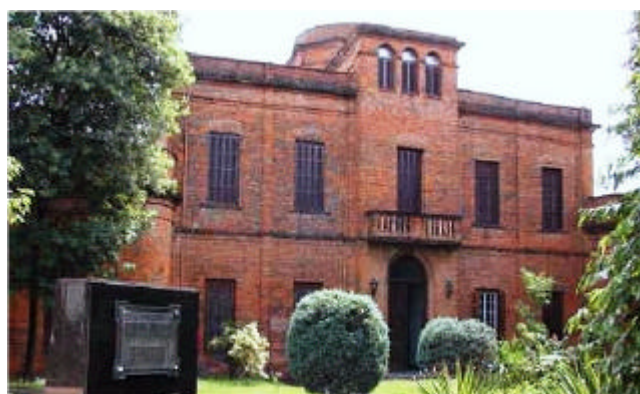
EDIFICIO FUNDACIÓN "LA PIEDAD" - Sede de la Academia Paraguaya de la Historia
