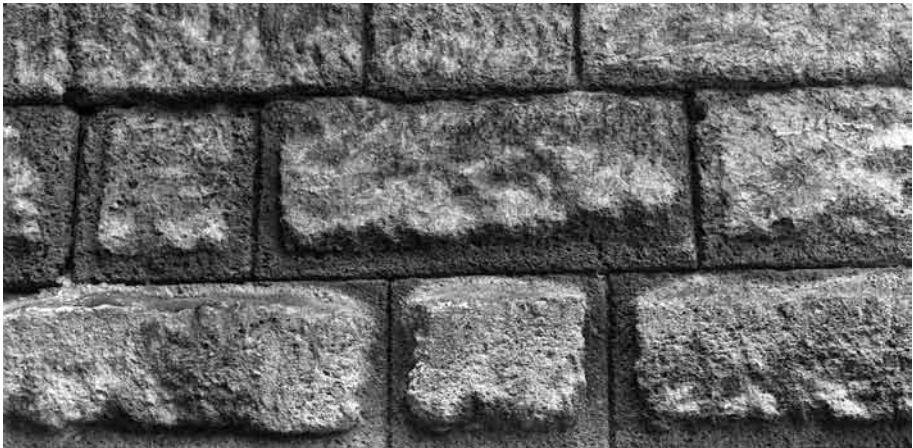
Fig. 7. Carmona. Puerta de Sevilla. Detalle del muro. Se identifica claramente el chaflán de los sillares.
