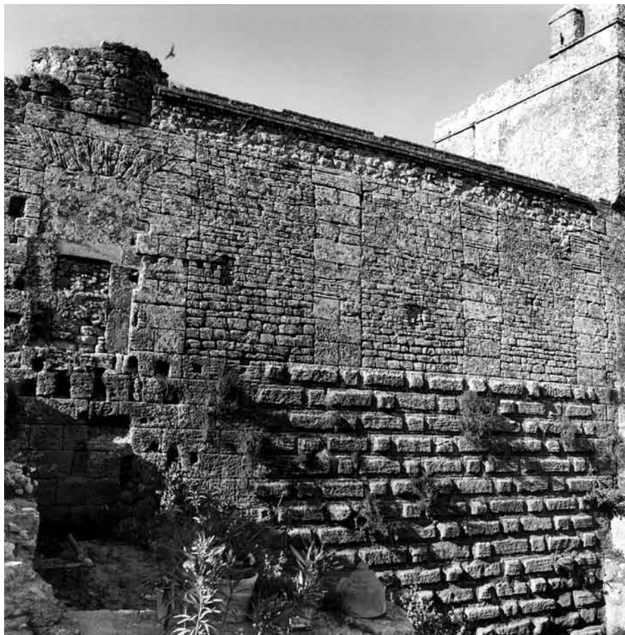
Fig. 10. Carmona. Puerta de Sevilla. Vista interior del muro sur del llamado bastión, en el año 1965, con el muro almohadillado en la parte inferior y la pared con inclusión de pilares y material de relleno en el ámbito superior.
